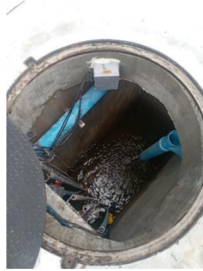
จุดที่ 4 บริเวณถังปรับสภาพสมดุลของระบบบำบัดน้ำ
